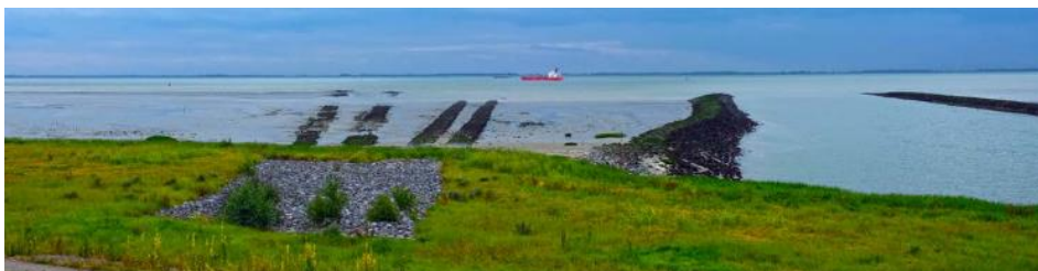
Figuur 2-11: Zeekabels en waterinlaat kerncentrale Borssele [14]
